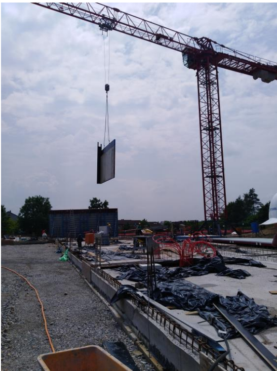
Erstellen einer Außenwand
